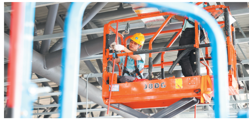
5月1日，在崖州区“三馆”项目建设现场，工人正在进行通风管道安装作业。 本报记者 李学仕 实习生 江文滔 摄
