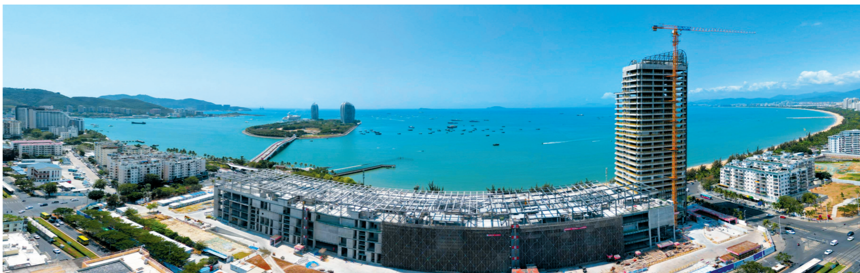
航拍正在建设中的三亚联合中央商务区项目。本报记者 李学仕 摄
