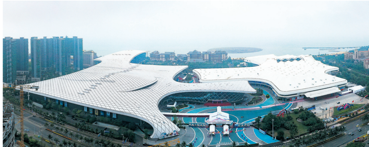
这是4月11日拍摄的第四届中国国际消费品博览会主会场海南国际会展中心(无人机拍摄照片)。新华社记者 郭程 摄
