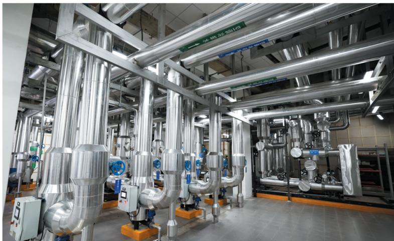
这是3月25日在博鳌近零碳示范区内博鳌亚洲论坛大酒店拍摄的改造后的制冷机房。作为建筑绿色化改造的项目之一，更换了高效设备设施系统的制冷机房工作将更加高效。
