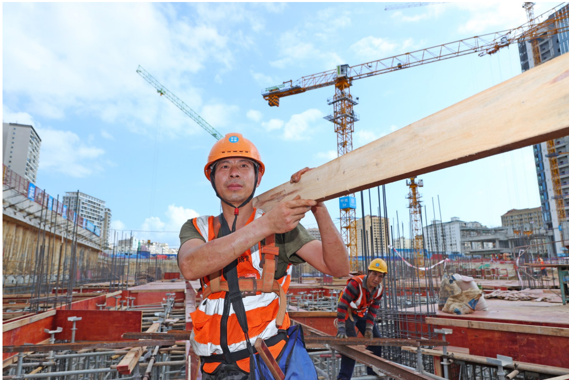
在三亚紫金家园项目现场，工人正在加紧施工。
