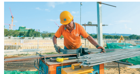
在海棠区北京大学口腔医院三亚分院项目，工人正在弯曲钢筋。
