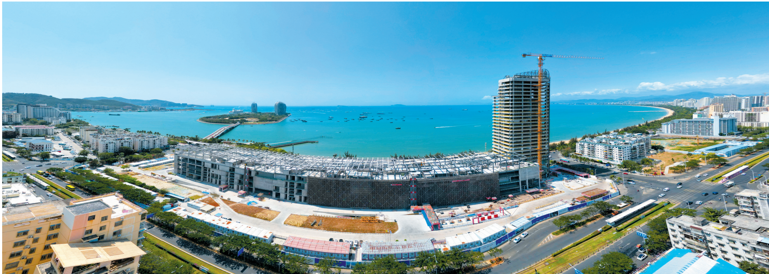
航拍正在建设中的三亚联合中央商务区项目。
