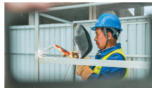
在南京农业大学大豆园艺作物种质创新中心项目，工人在焊接库房钢架。
