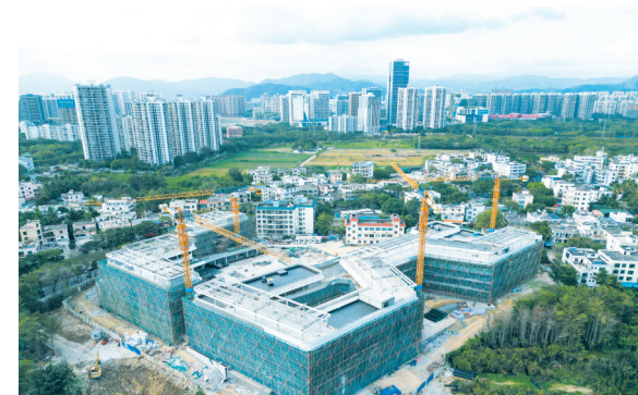
航拍位于三亚CBD海罗单元的海罗小学改扩建项目。
