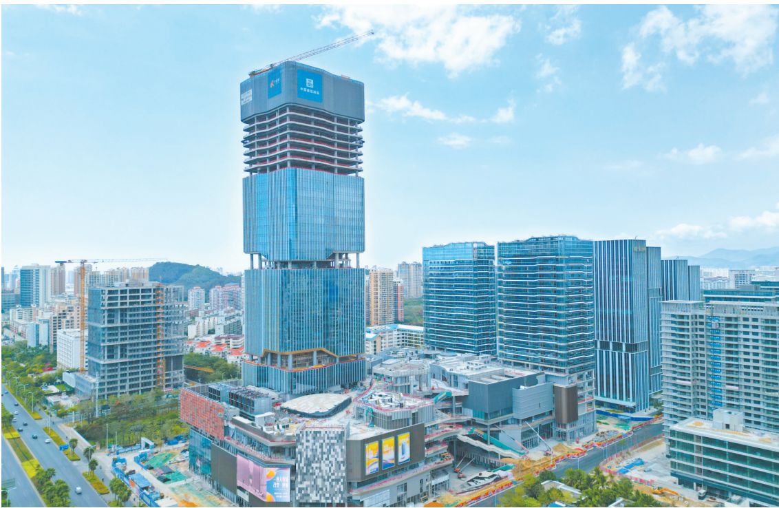
航拍正在建设中的中粮·三亚大悦中心项目。
