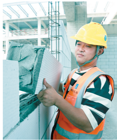
2月28日,南京农业大学大豆园艺作物种质创新中心项目,工人正在进行砌筑工程作业。
