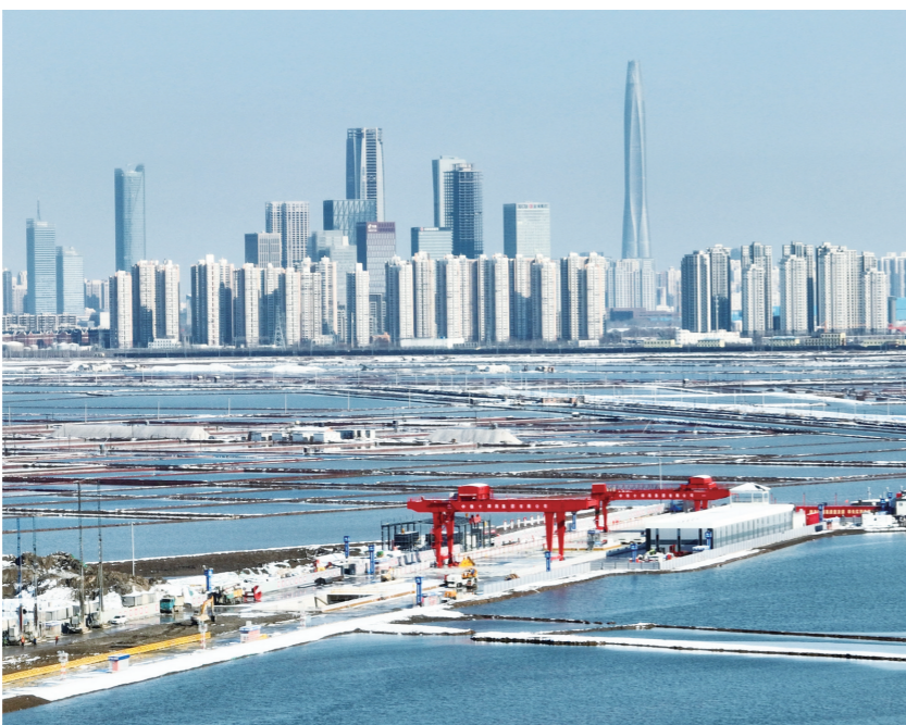
2024年1月18日拍摄的盾构机始发现场(无人机照片)。当日,由中铁十四局承建的津潍高铁津沽海河隧道超大直径盾构机“津城一号”顺利始发,标志着京津冀地区开挖直径最大、掘进距离最长的高铁盾构隧道正式开始掘进。 新华社记者 邢广利 摄
