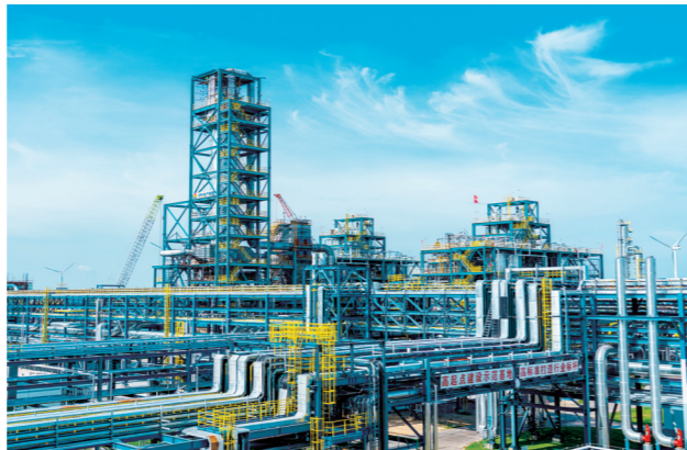
海南华盛新材料科技有限公司生产装置。
