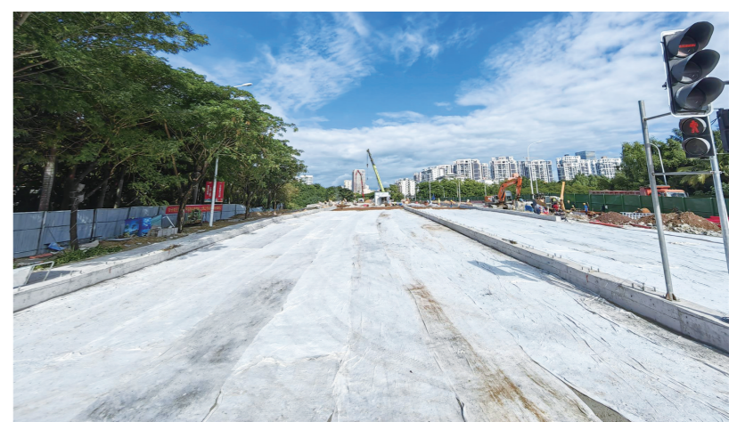
丹州桥桥面垫层施工已完成。赵庆山 摄
