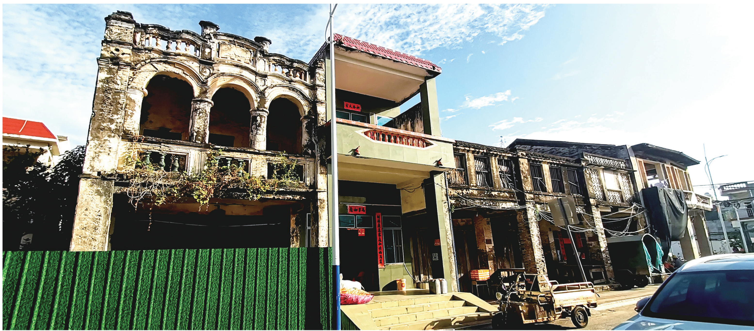
崖州区临高村铺仔市路口的骑楼群，最左侧有围挡的即为郑绍材故居。本版图片 本报记者 王鑫 摄
