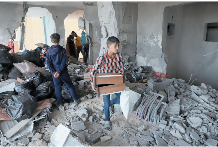
11月22日，在加沙地带南部城市汗尤尼斯，巴勒斯坦人查看遭以色列袭击后的建筑废墟。 新华社发（里泽克·阿卜杜勒贾瓦德 摄）
