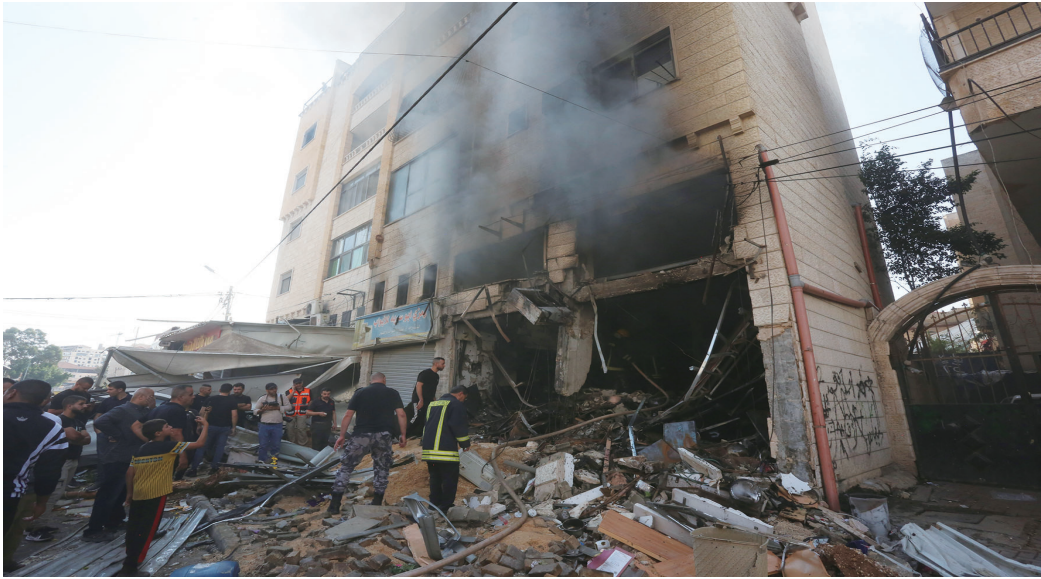
人们查看一处损毁的建筑。新华社发（尼达尔·艾什塔耶摄）
