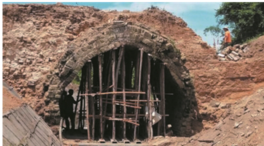
2016年修缮广济桥现场。通讯员 孙建平 摄
