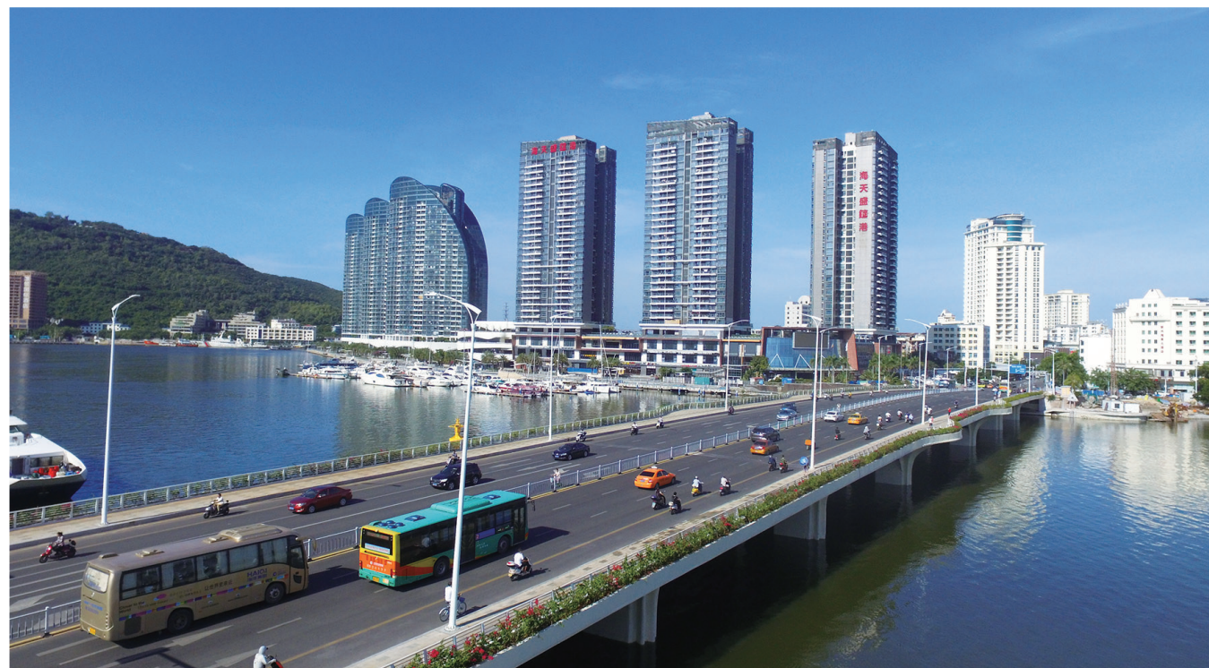
改造后的三亚大桥。孙清摄
