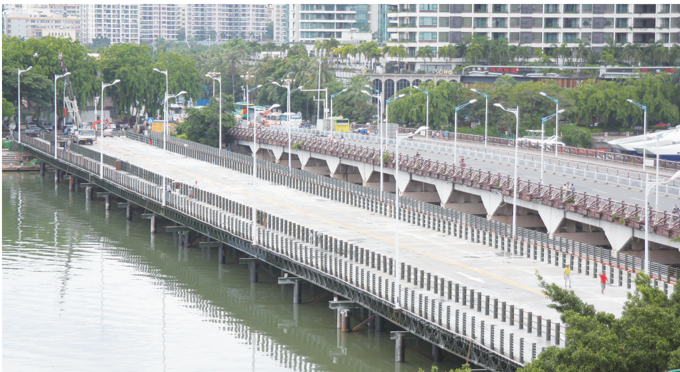
改造前的三亚大桥。孙清摄
