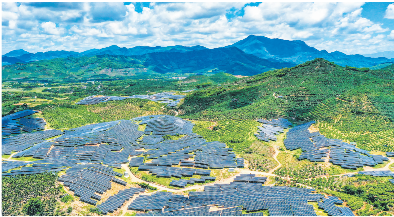
蓝天白云下,俯瞰大唐三亞红星光伏发电电站,阳光注入一排排光伏板上,源源不断地输送绿色电,为三
