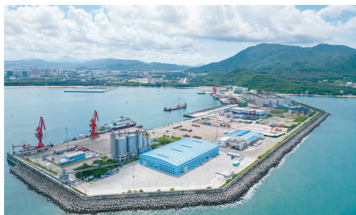
5月25日，俯瞰三亚港南山港区对外开放口岸、“二线口岸”现场查验能力建设项目。本报记者陈聪聪摄
