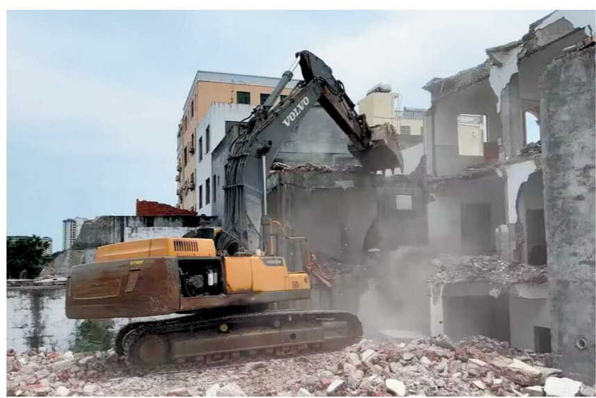
6月16日,工作人员对芒果村11栋棚改范围内的房屋进行拆除。黄世烽 摄
