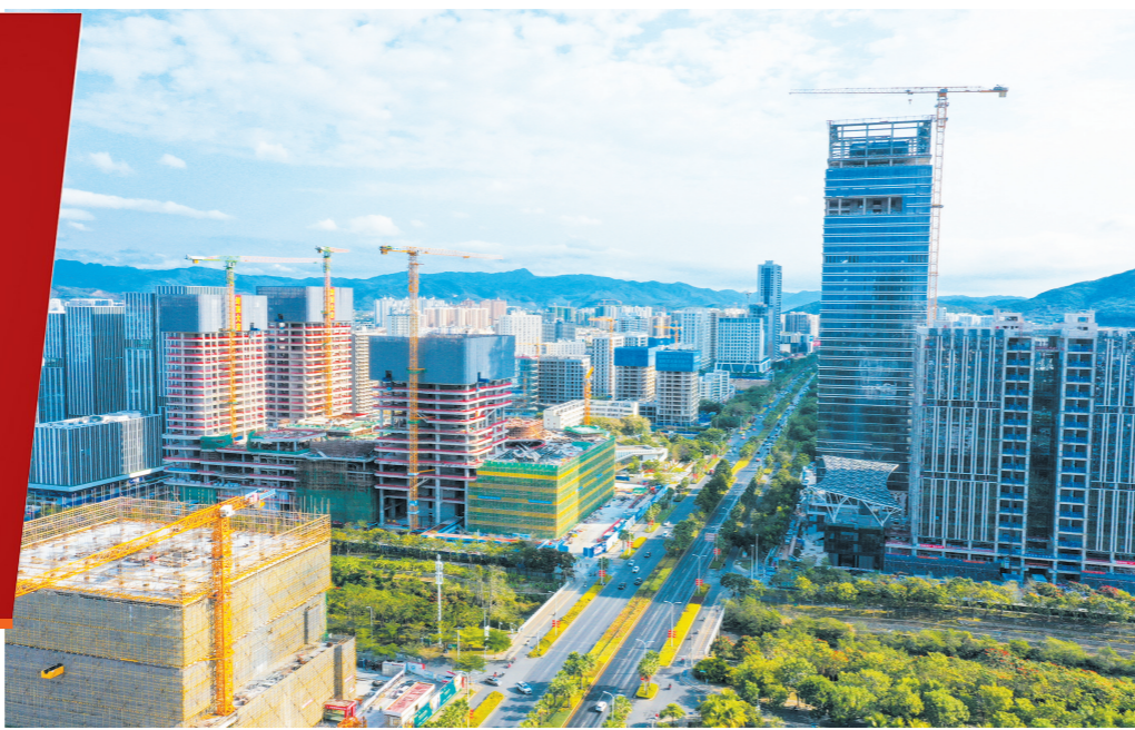
俯瞰三亚中央商务区东岸片区，迎宾路两旁的重点项目加快建设。本报记者 陈聪聪 摄
