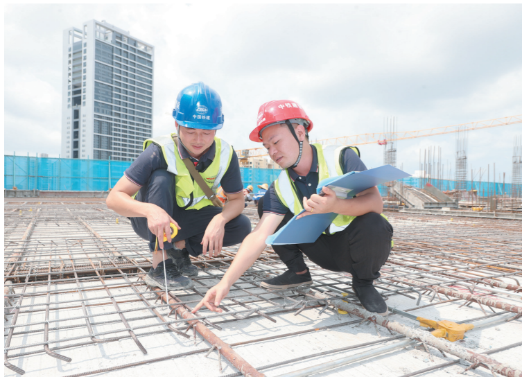
左俊(右)与同事认真检查施工情况。本报记者 李学仕 摄
