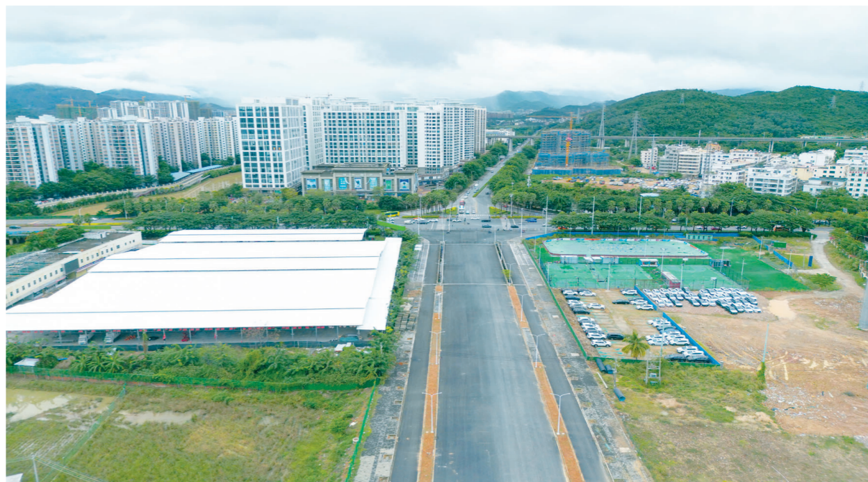
11月22日，航拍三亚学院路延伸段工程项目。本报记者 李学仕 摄
