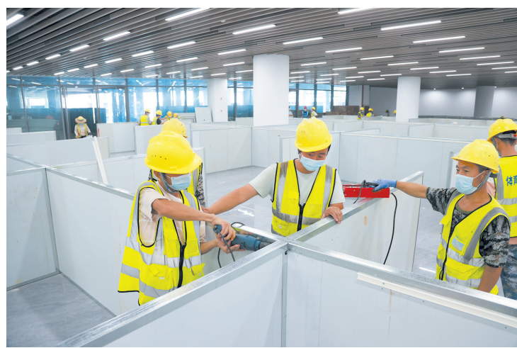
8月12日,在三亚第三方舱医院项目现场,工人们加紧安装隔离病床区挡板。 本报记者 陈聪聪 摄
