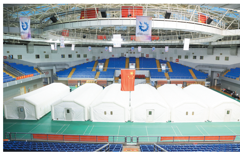
8月8日,经过工作人员加班加点搭建,位于三亚技师学院室内体育馆的气膜方舱实验室建成并投入使用。该实验室是三亚市首个气膜方舱实验室,由广州华银康医学检验中心负责搭建、运营及维护,每日核酸检测量可以超过10万管。 本报记者 陈聪聪 摄
