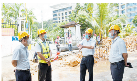
张秀标(右二)指导南繁基地核酸检测实验室排水项目建设。
