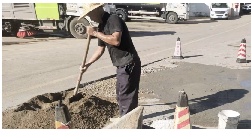
右图:工作人员对渗漏污水的缝隙进行修补。本报记者 黄世烽 摄
