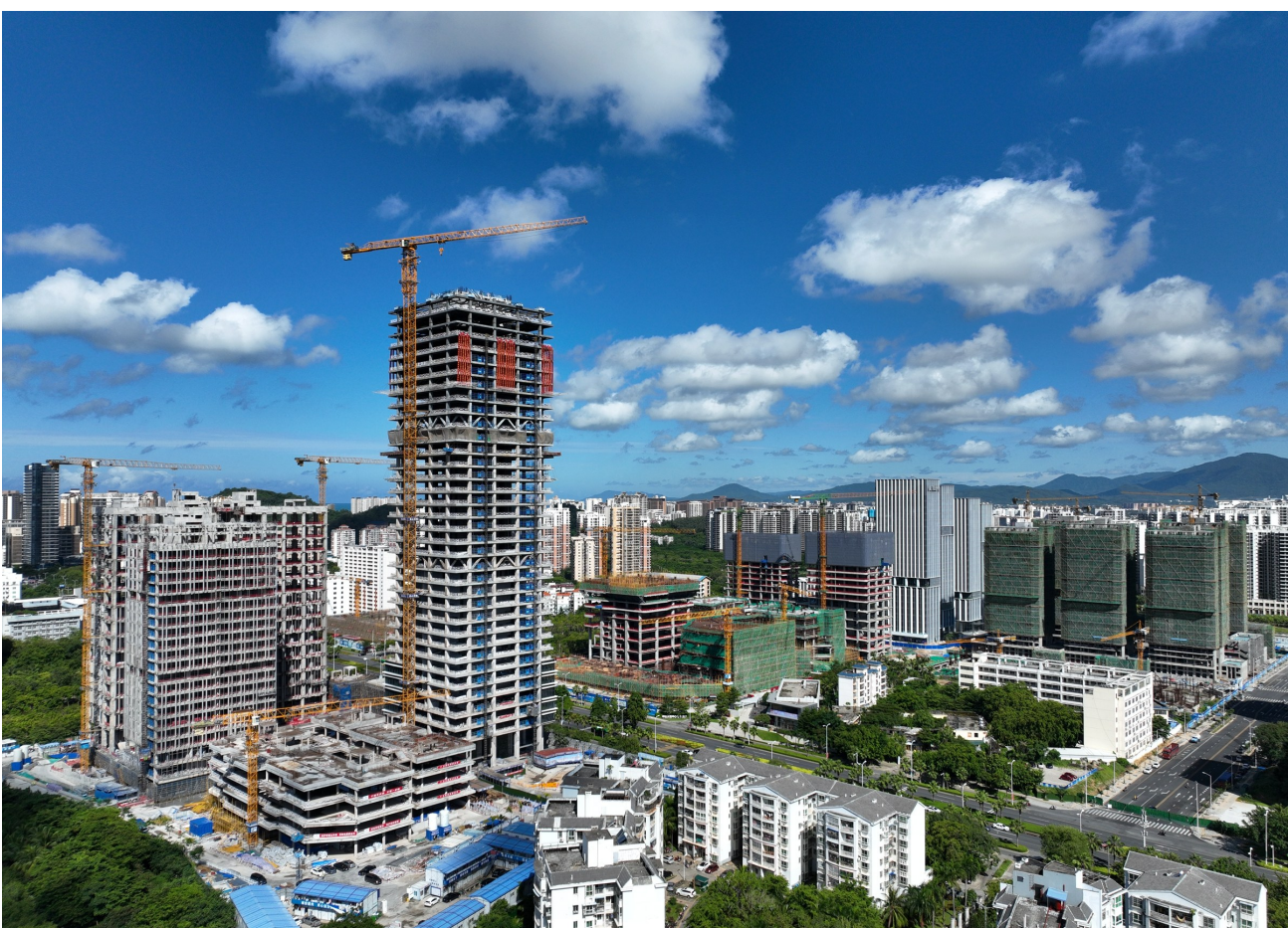
7月22日，高空俯瞰当天顺利封顶的总高度186.9米的三亚中交国际自贸中心总部大楼。本报记者 袁永东 摄
