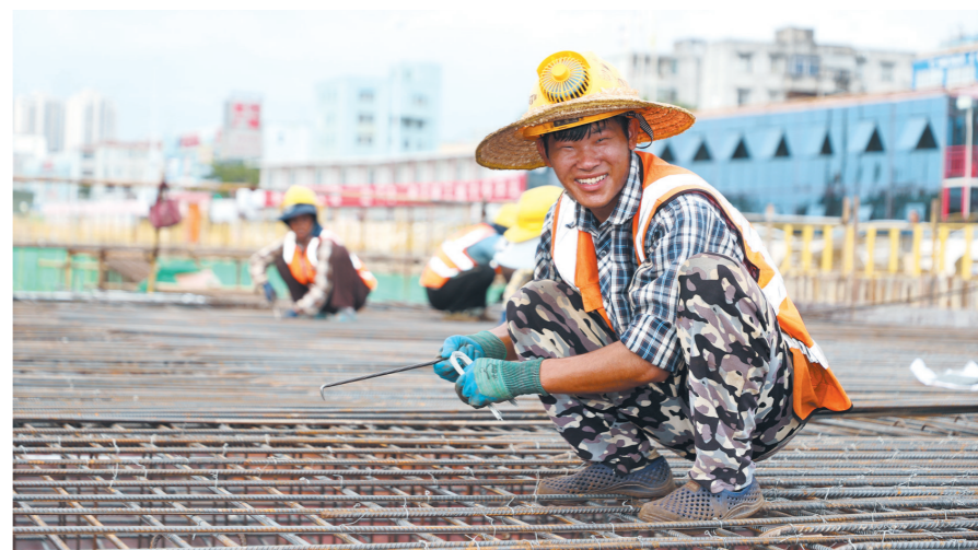
“穿针引线” | 工人在三亚合联中央商务区项目建筑工地上干劲十足。
