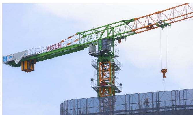
飞鸟挽票 | 三亚大悦城综合体项目工地,塔吊正在运送建筑材料。
