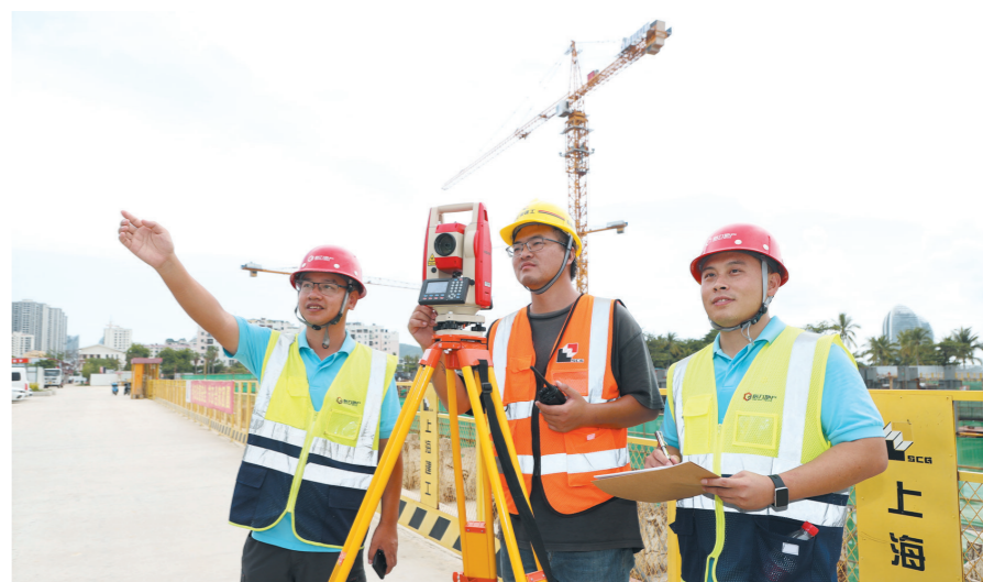
绘就蓝图 | 建设者在三亚合联中央商务区项目建筑工地进行测绘作业。
