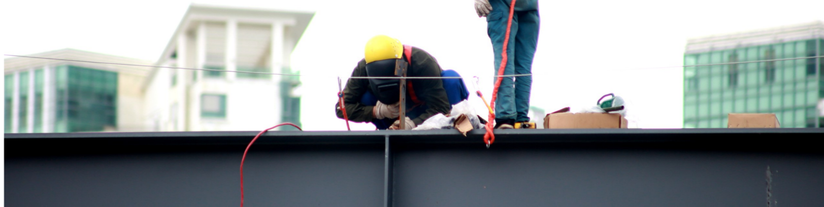
焊接牢固 | 南边海国际游艇荟项目工地上,电焊工正在进行高空焊接作业。
