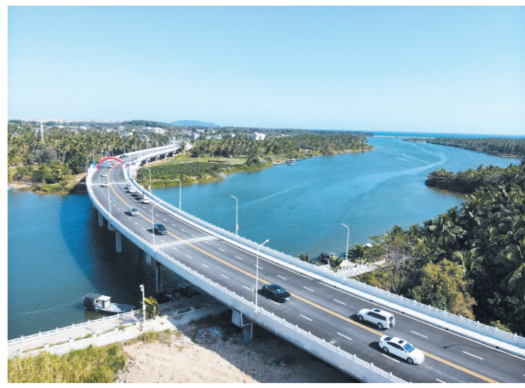
航拍海南省环岛旅游公路陵水土福湾至三亚海棠湾通道工程藤桥河特大桥段。
