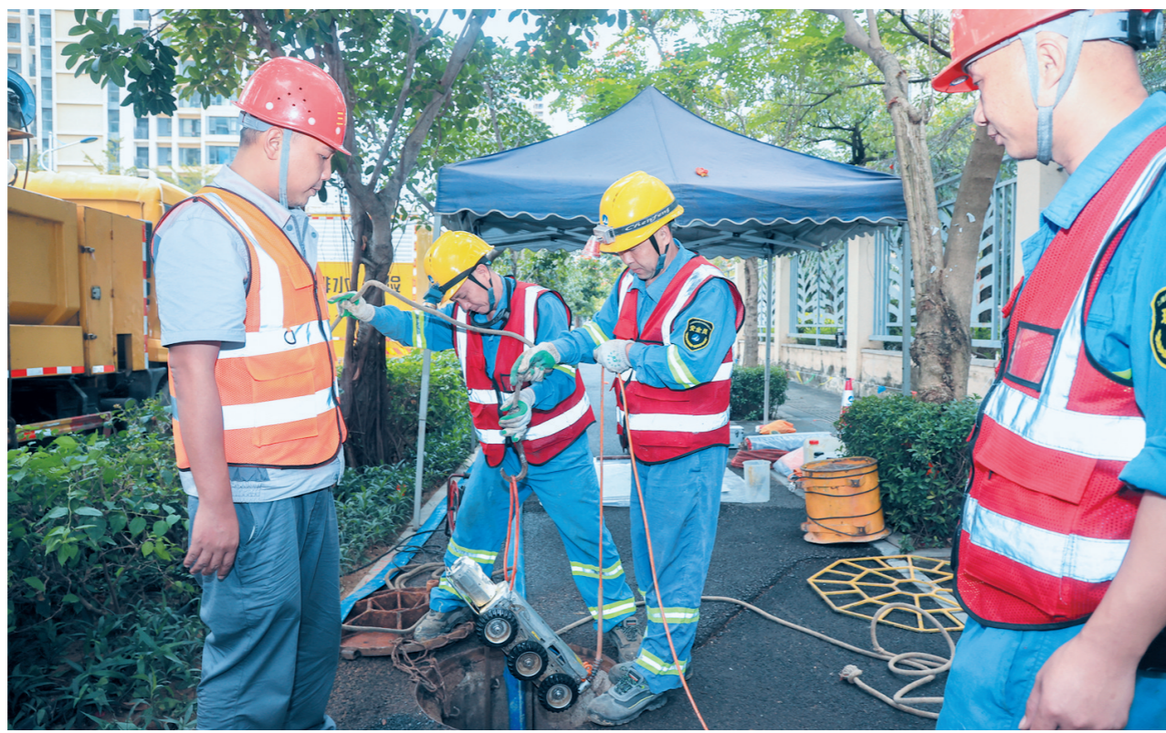
施工人员把“侦察员”——CCTV(中央控制工业管道内窥摄像)检测设备送入井中进行管道检测。本报记者 陈聪聪 摄
