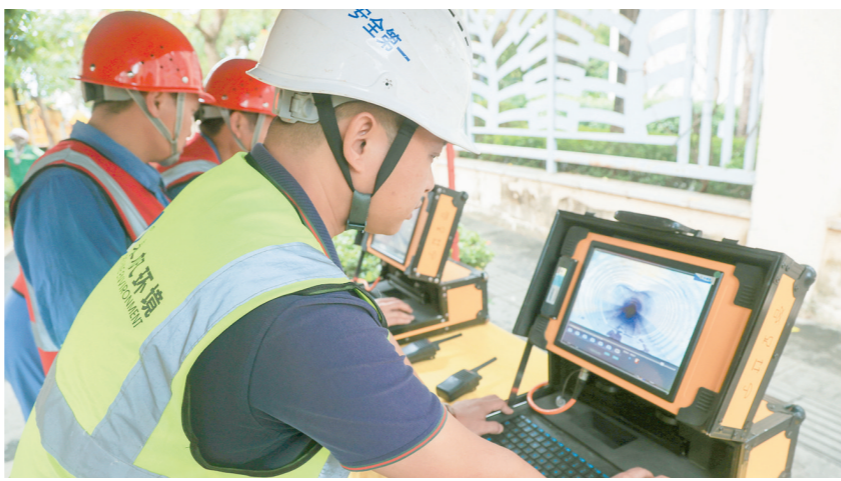
施工人员在电子屏幕上查看“侦察员”——CCTV检测设备在管道内拍摄的画面。
