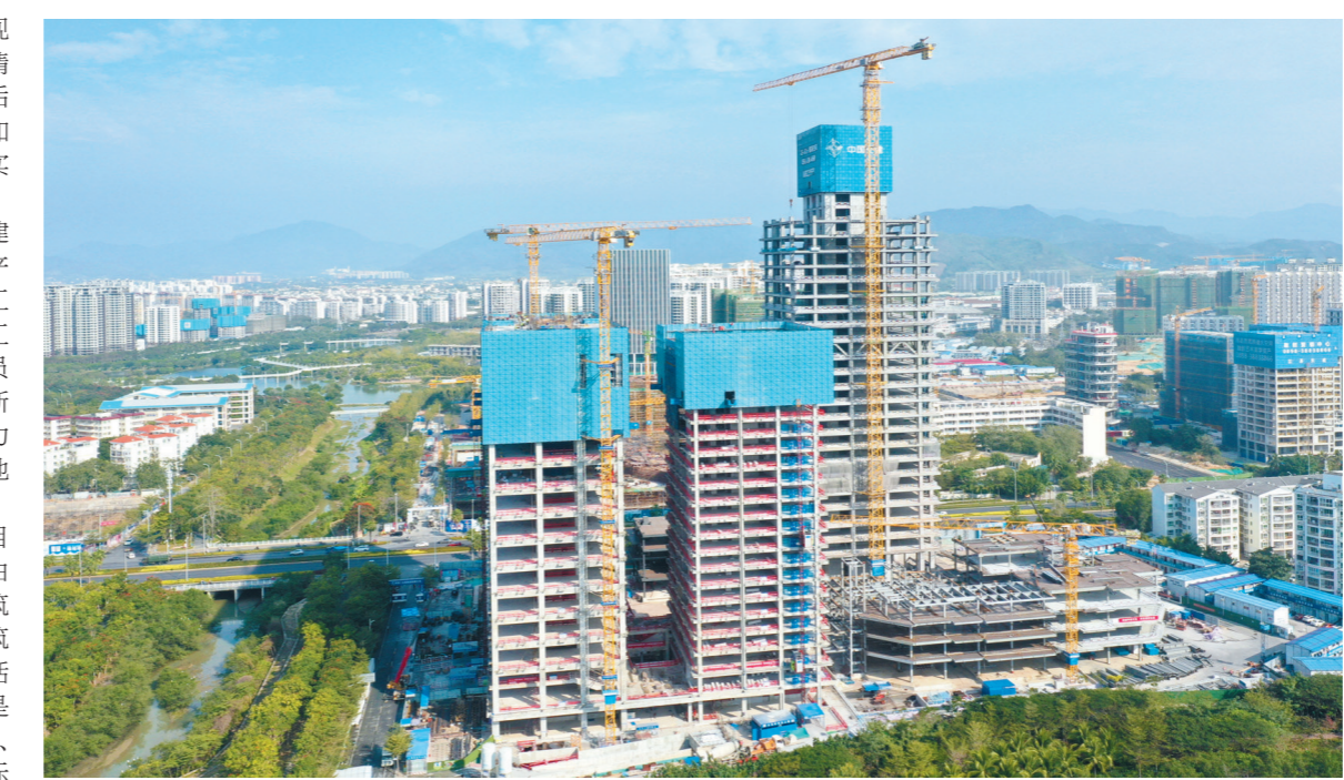
3月19日，中交海南总部基地项目A地块2号楼实现主体结构封顶。本报记者 李学仕 摄
