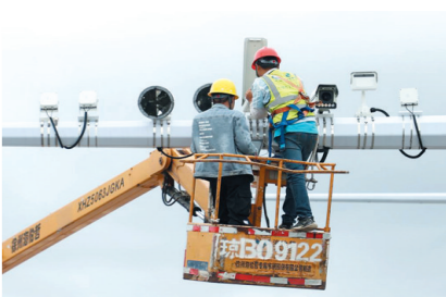
近日,工人在崖州湾科技城主干道十字路口安装监控设备。 本报记者 李学仕 摄
