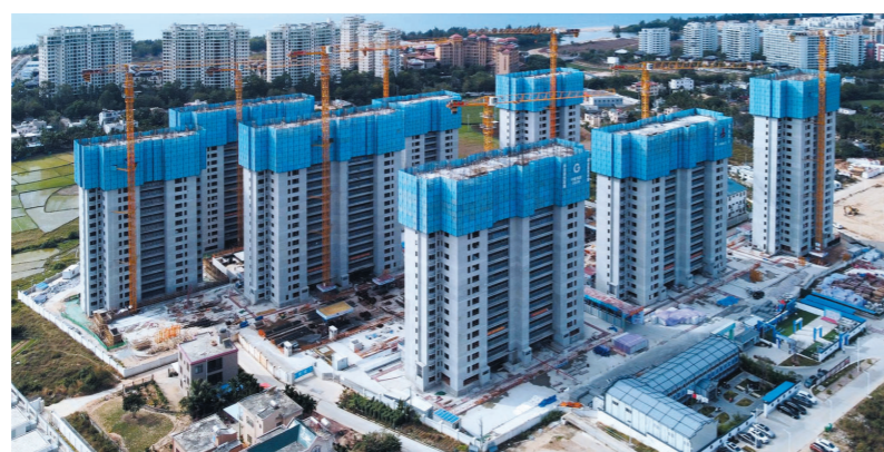
正在建设中的布甫安居房项目。本报记者 李学仕 摄
