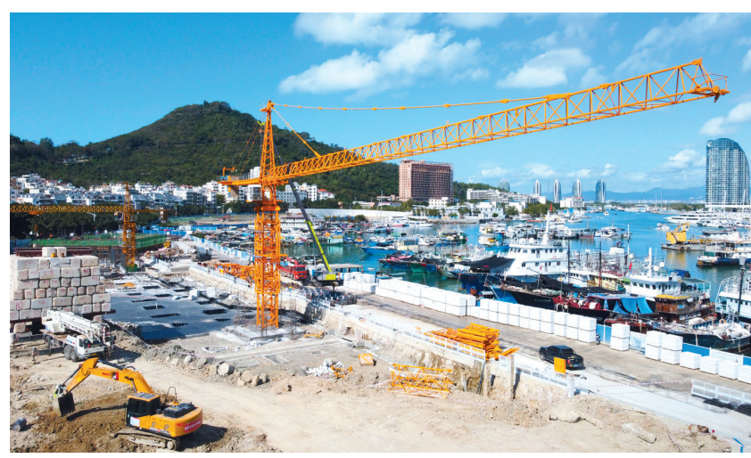
1月23日,航拍正在加速建设中的三亚国际游艇中心项目。本报记者 李学仕 摄
