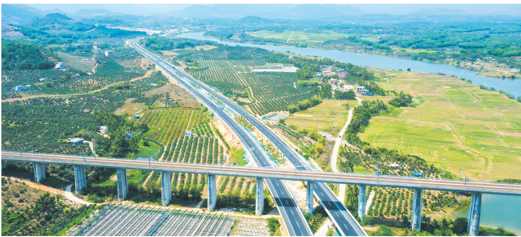
山海高速公路海棠湾路段。 本报记者 陈聪聪 摄
