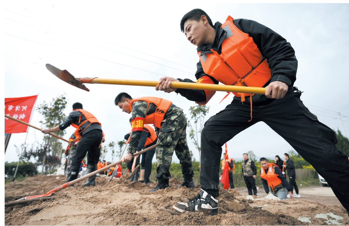
10月10日,在山西省河津市阳村街道连伯村,抢险人员在加固临时堤坝。新华社记者 詹彦 摄
