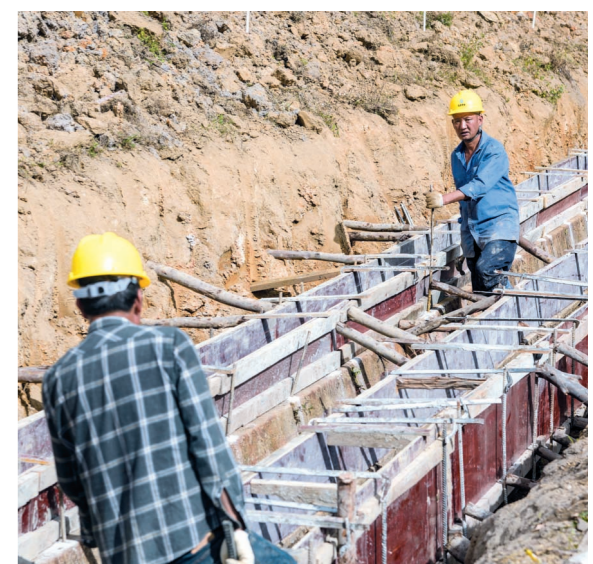
工人们正在整修水渠。本报记者 刘琪成 摄
