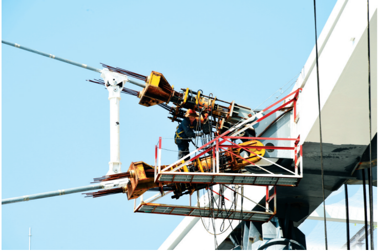
工人在体育场顶部调整索结构。本报记者 陈聪聪 摄
