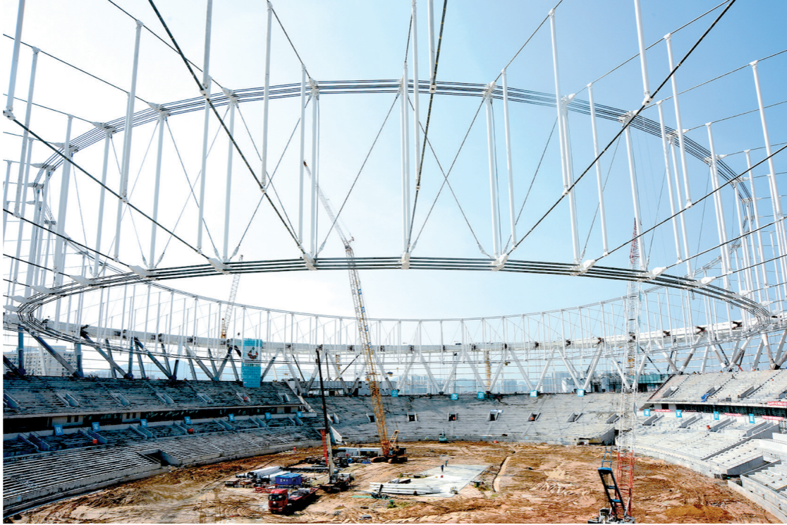
8月31日上午，三亚国际体育产业园体育场项目索结构张拉提升工程施工全部完成，标志着体育场钢结构、索结构整体状态达到了初始态。 本报记者 陈聪聪 摄
