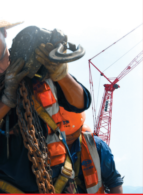
工人正在操作索结构张拉设备。 本报记者 陈聪聪 摄
