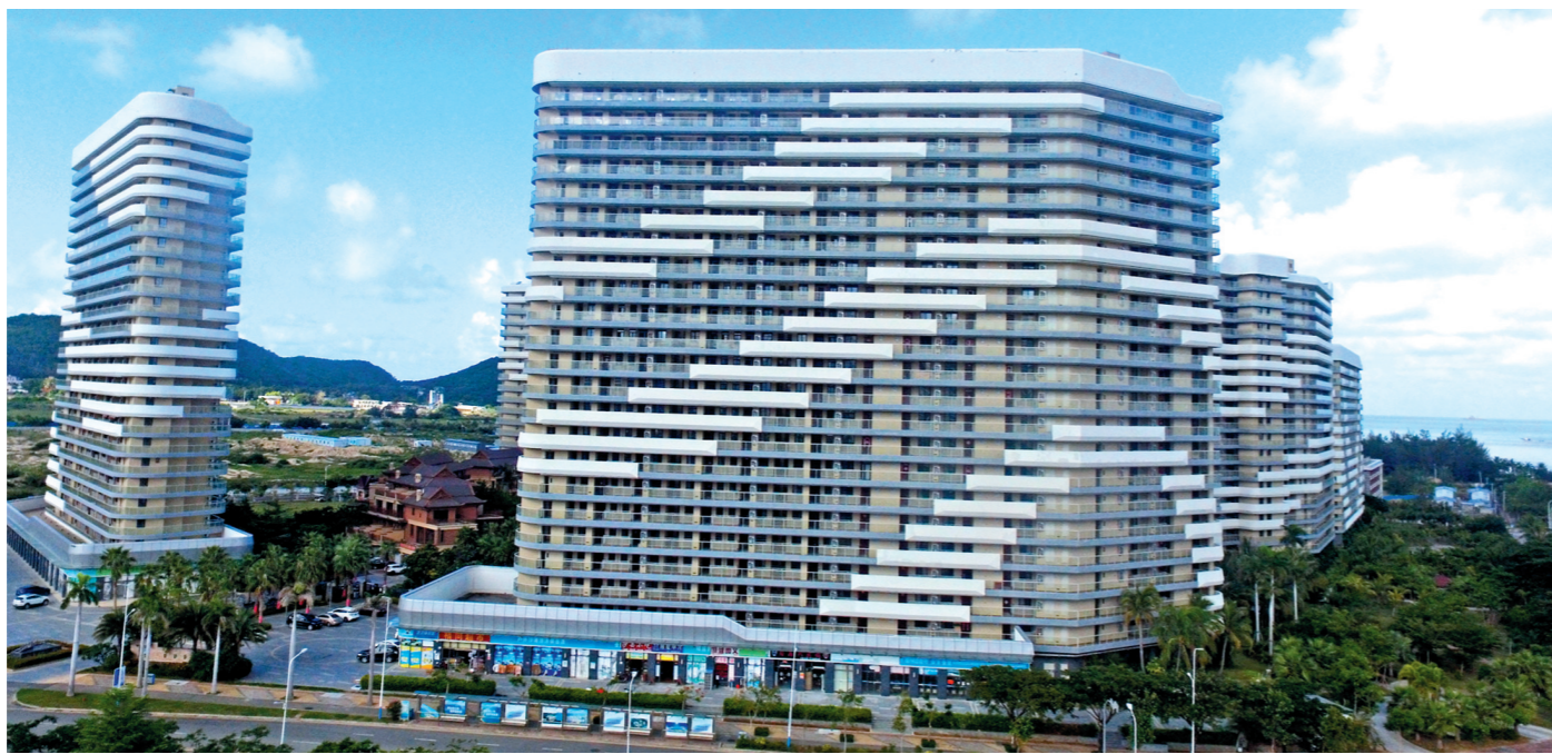
建设中的三亚崖州湾科技城。本报记者 孙清 摄
