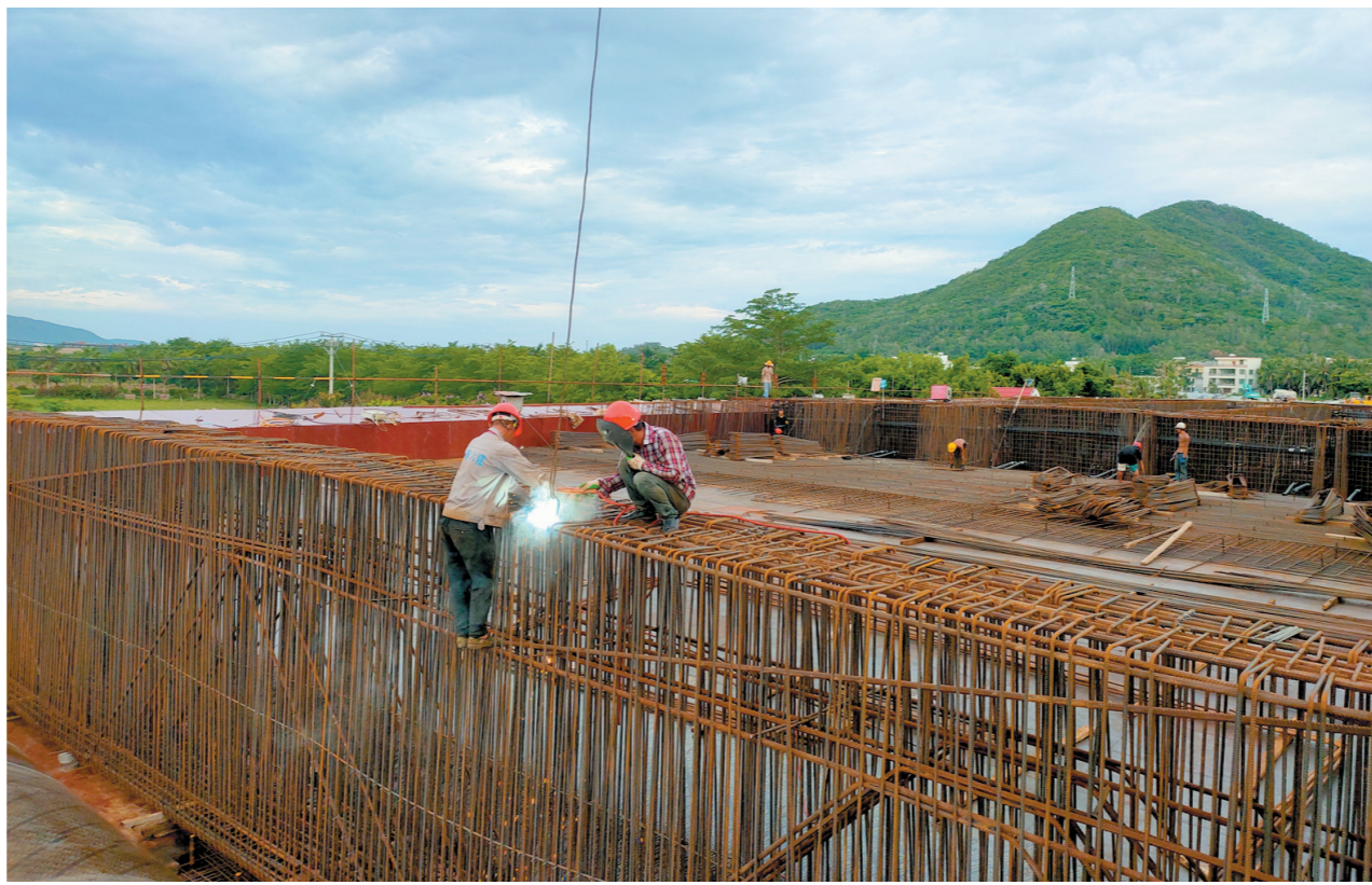
亚龙湾第二通道玫瑰谷大桥现场,工人正加紧施工。本报记者 赵庆山 摄
