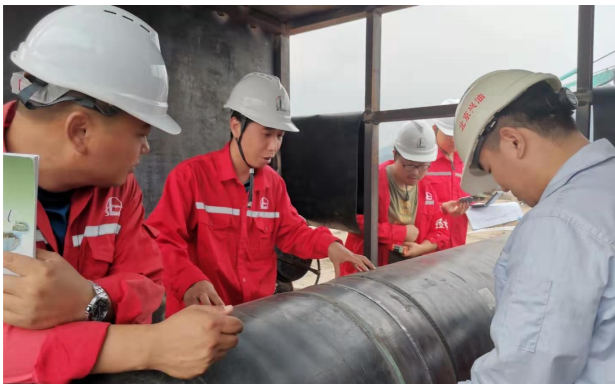
施工团队正在对管道焊接外观进行检查。本报记者 李少云 摄
