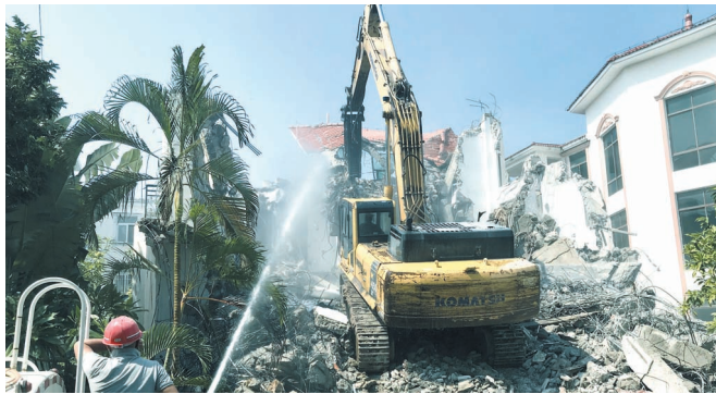
执法部门对违法建筑实施拆除。本报记者 黄世烽 摄
