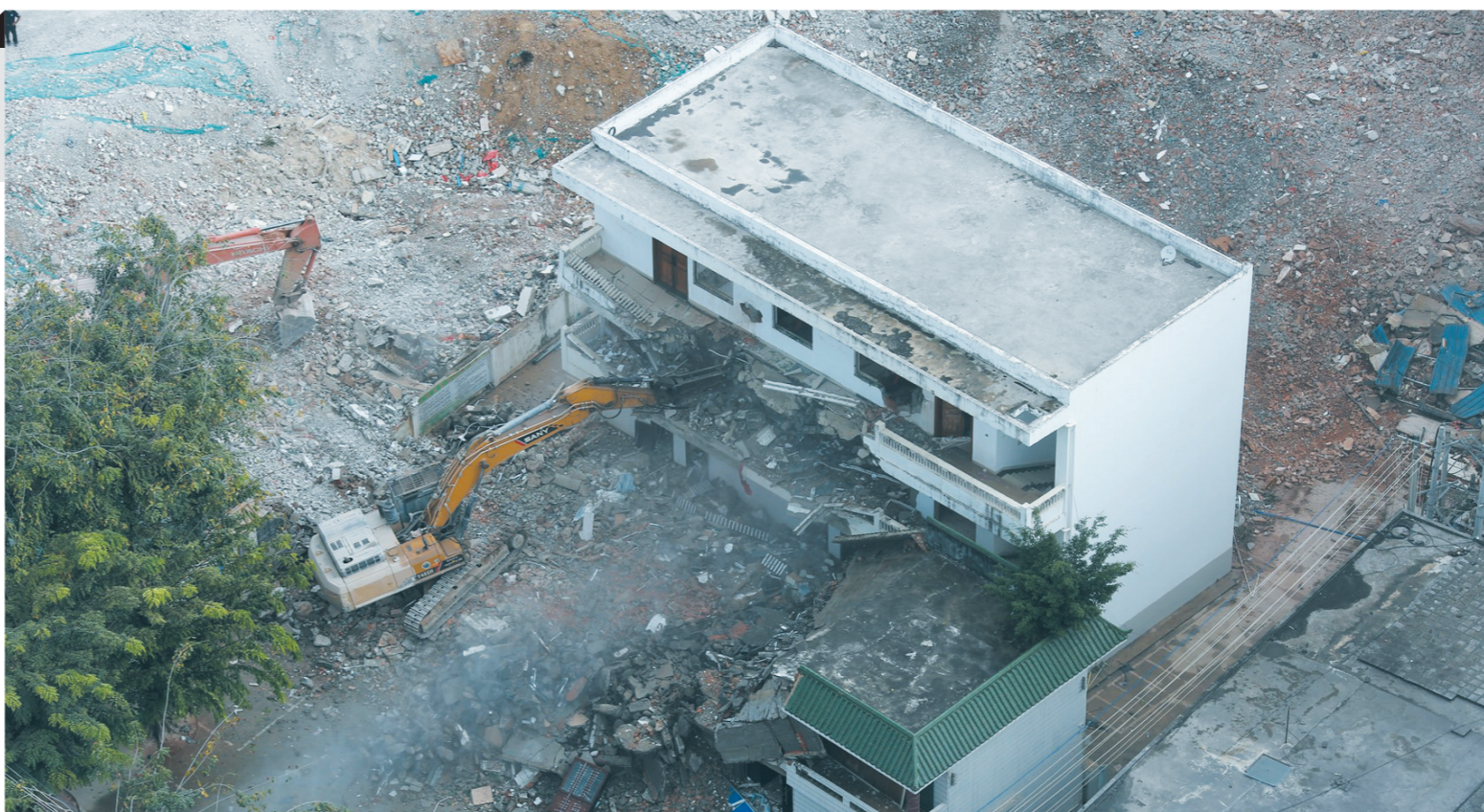
大型机械入场,开始拆除月川居委会。
