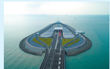
港珠澳大桥香港段人工岛(10月13日无人机拍摄)。
