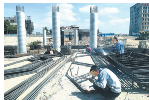
烈日下,工人正在挥汗如雨地施工。本报记者 林志猛 摄
