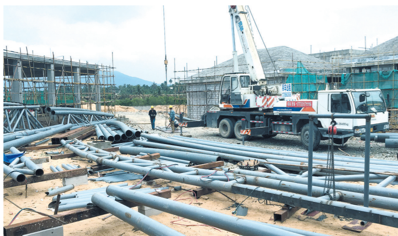
三亚海昌梦幻不夜城项目加紧施工。汪慧珊摄
