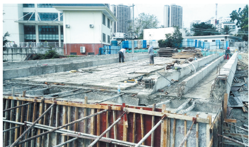
工人在金鸡岭桥头公园连接桥项目工地施工。吴英模摄
