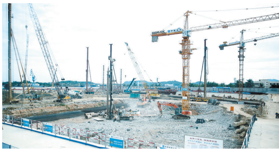
9月4日,红沙污水处理二厂建设工地,机器轰鸣,车辆来往,工人们正在加快工程建设。本报记者 袁永东 摄
