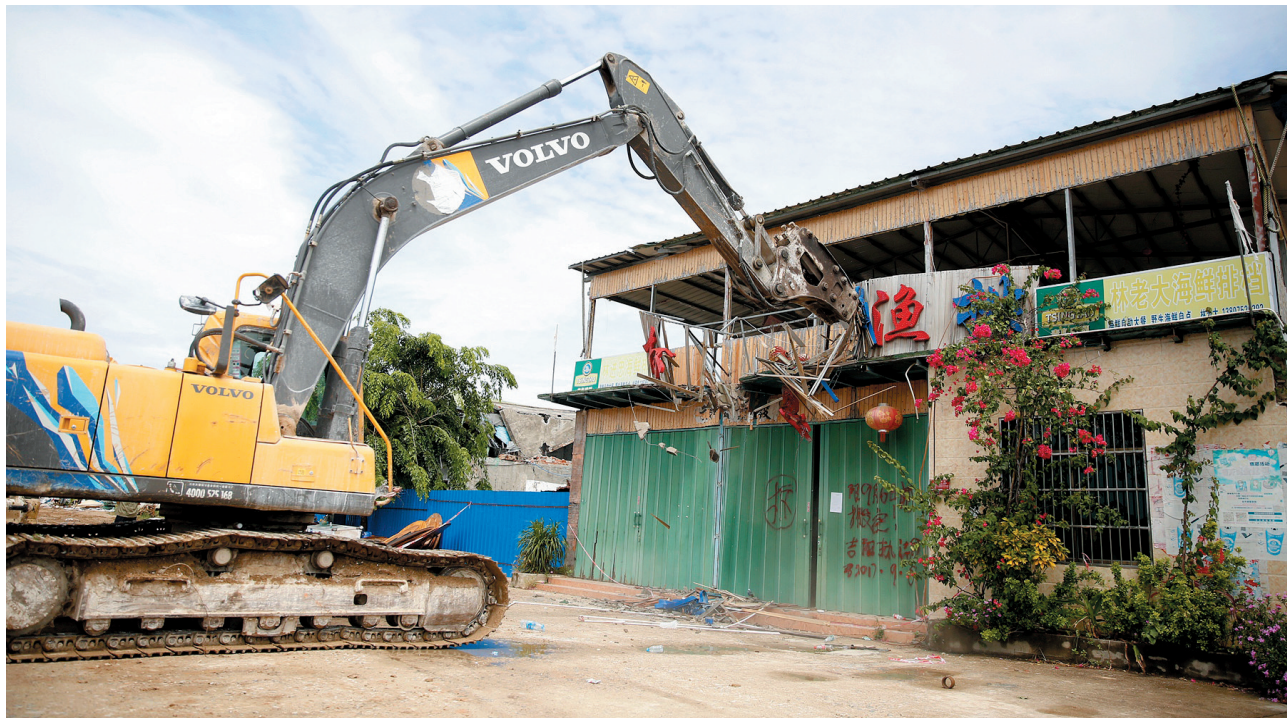
9月7日,吉阳区海洋渔业、城管等部门组织力量对红沙码头的17家违建海鲜排档进行依法拆除。本报记者 袁永东 摄
