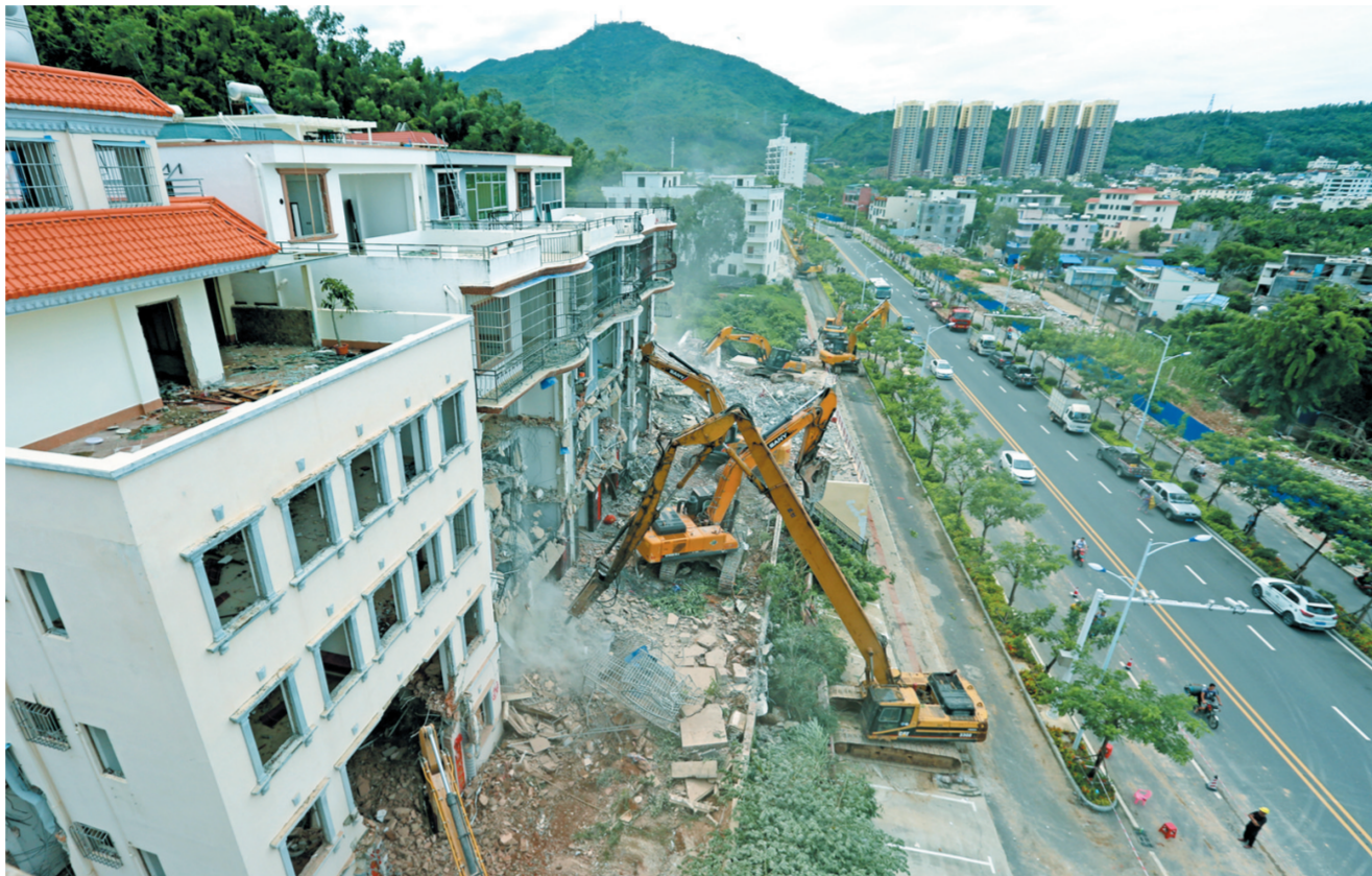
7月29日,吉阳区城管局组织力量拆除临春多栋房屋,加快棚改步伐。本报记者 孙清摄
