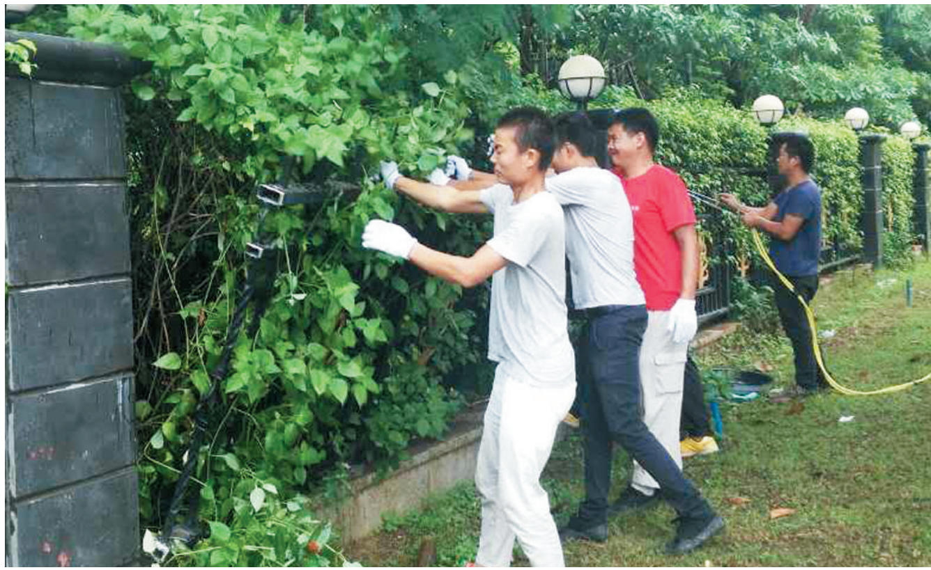
工作人员正在拆除名花公园铁围栏。本报记者 汪慧珊 摄
