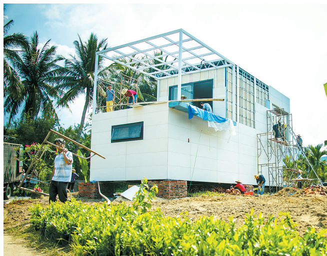
工人们正在搭建装配式别墅酒店。本报记者 翁叶俊 摄
