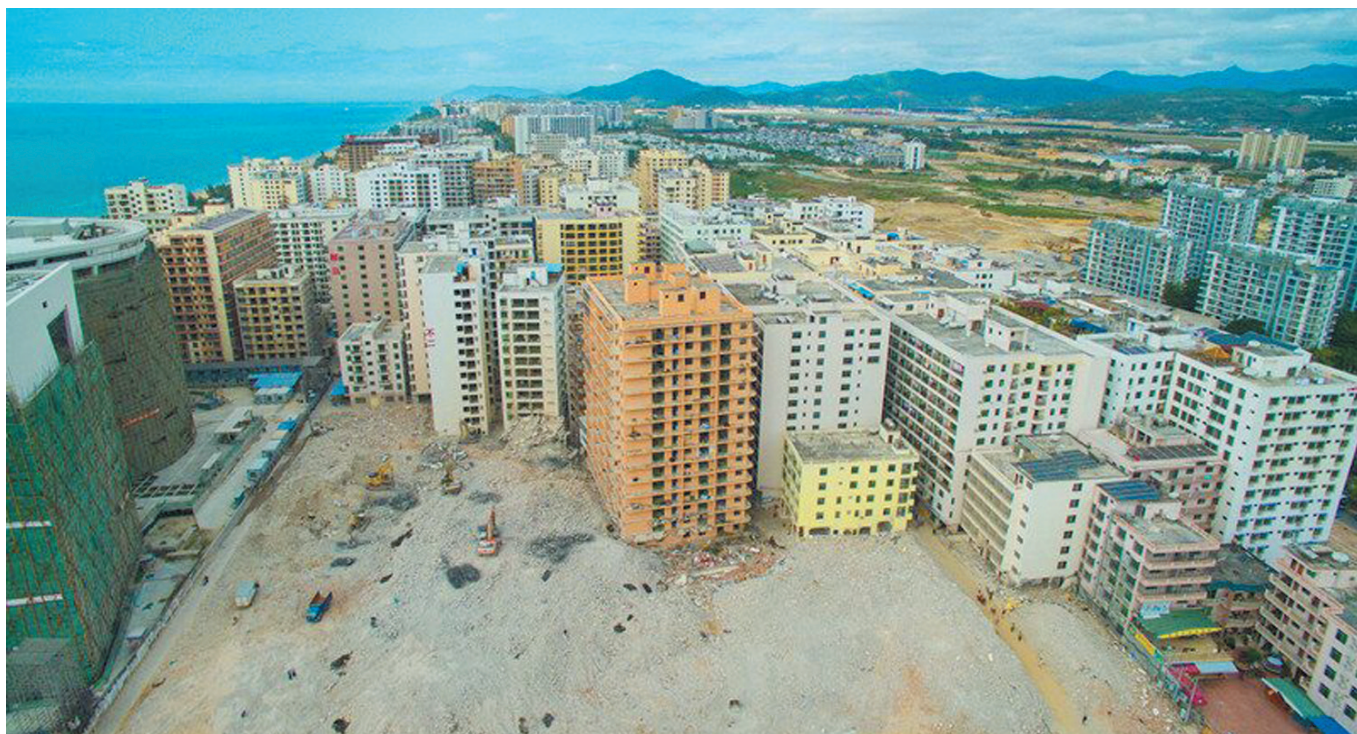
海坡自然村违建未拆除前,楼房建设十分拥挤、密集,存在严重的消防安全隐患。黄世烽 摄
