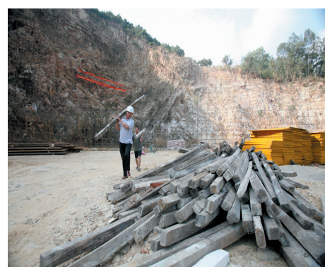
工人正在搬运施工材料。本报记者 翁叶俊 摄
