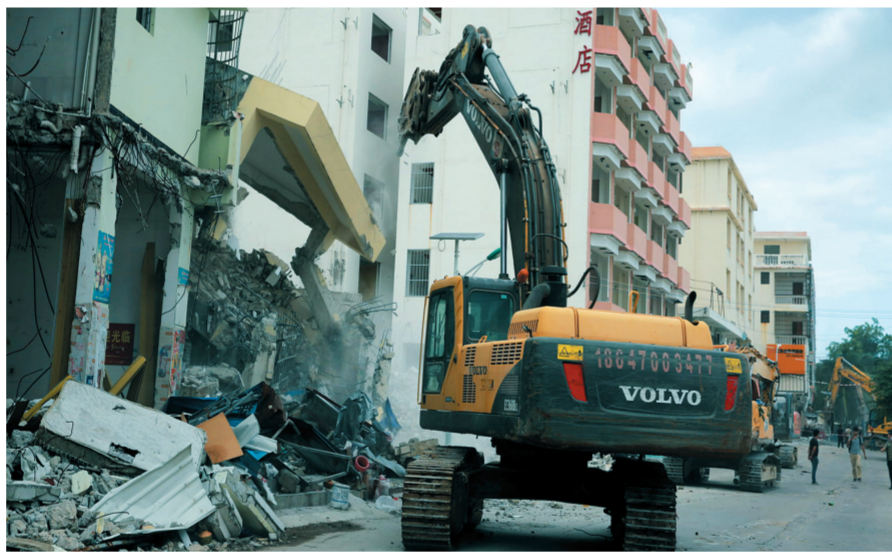
11月11日,吉阳区城管局出动多台机械,对房屋进行拆迁。本报记者 孙清摄
